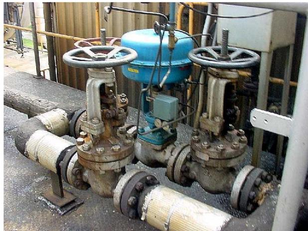
Figura 189. Instalação de uma válvula gaiola balanceada
