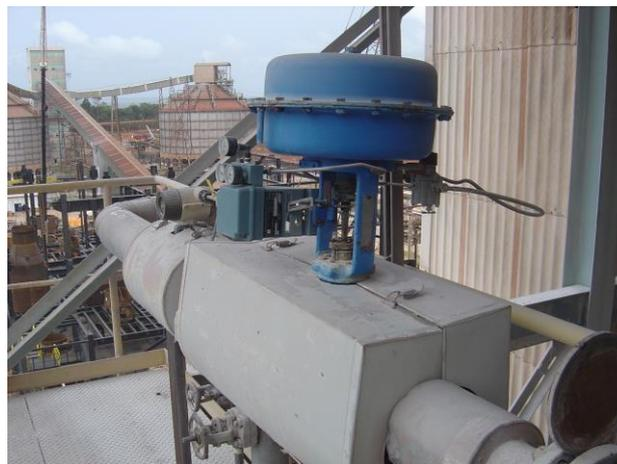
Figura 172. Instalação de uma válvula com atuador mola diafragma
