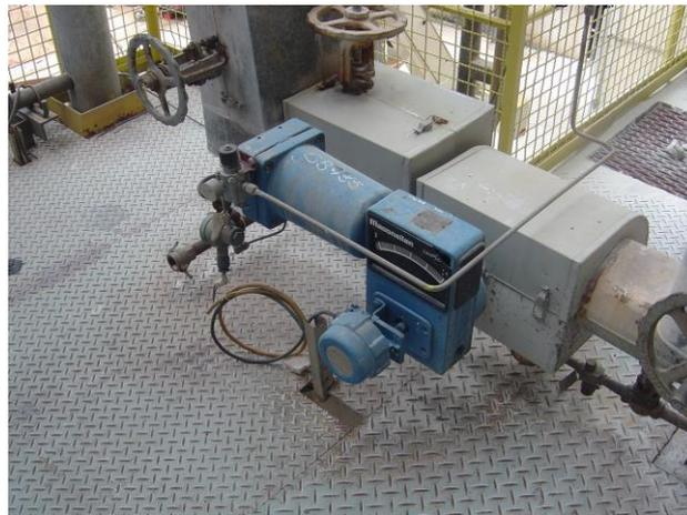
Figura 201. Instalação de uma válvula camflex II
