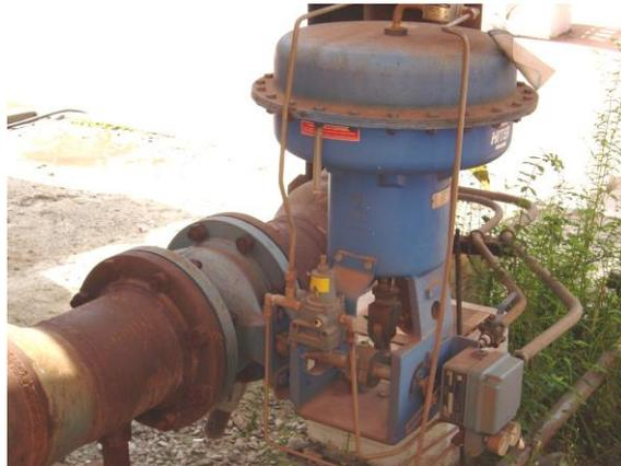
Figura 194. Instalação de uma válvula borboleta
