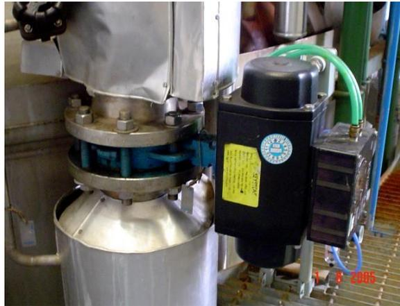
Figura 176. Instalação de uma válvula com atuador dupla ação
