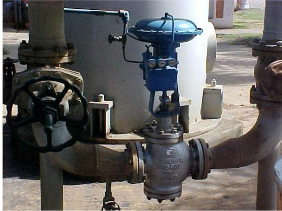
Figura 185. Instalação de uma válvula globo sede dupla
