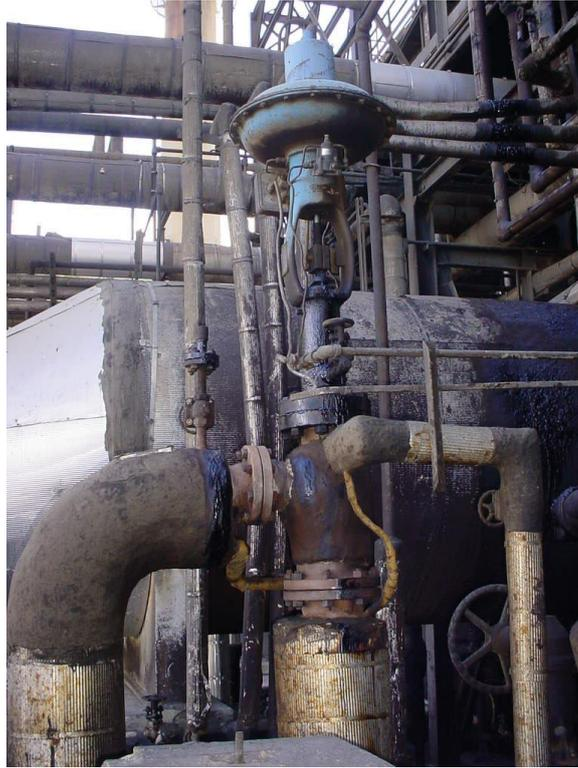
Figura 192. Instalação de uma válvula 3 vias
