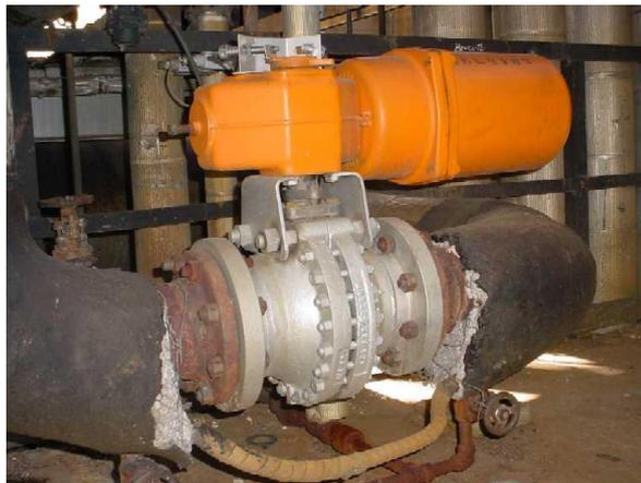
Figura 199. Instalação de uma válvula esfera
