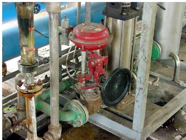
Figura 183. Instalação de uma válvula com volante manual
