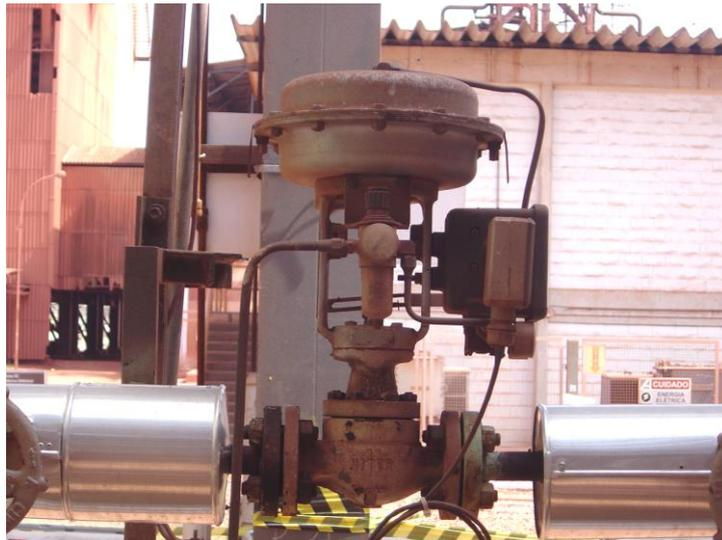
Figura 182. Instalação de uma válvula globo sede simples
