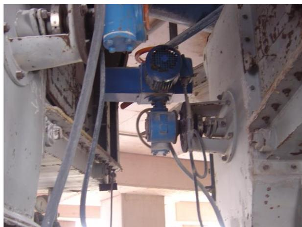
Figura 178. Instalação de uma válvula com atuador elétrico
